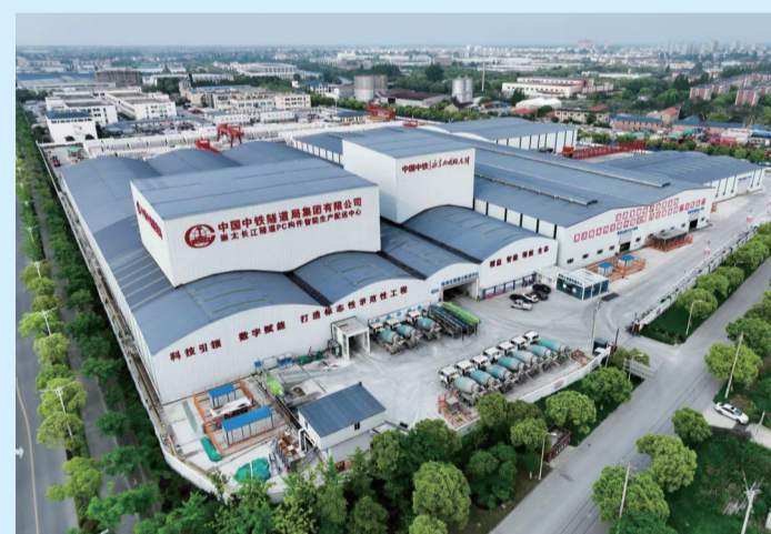
崇太长江隧道PC构件智能生产配送中心
